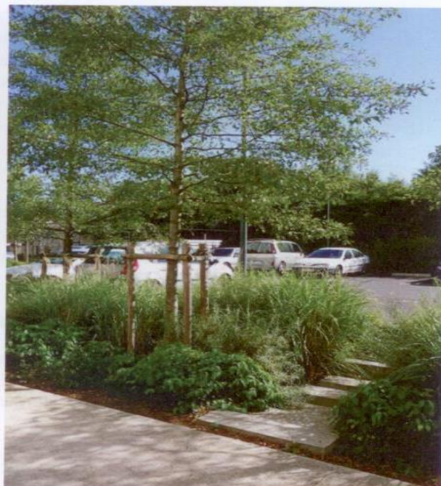
Figure 26 : A gauche : place yitzhak rabin-yasser arafat, Bobigny. Les bordures interrompues (à gauche) permettent l'écoulement des eaux de pluie vers l'espace vert et la noue (à droite).
