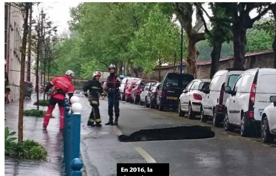
En 2016, la chaussée s'était effondrée rue des Pommiers, du fait de la dissolution du gypse sous-terrain. Pour combler ce fontis, l'équivalent en béton du volume de la tour Eiffel a été déversé.
