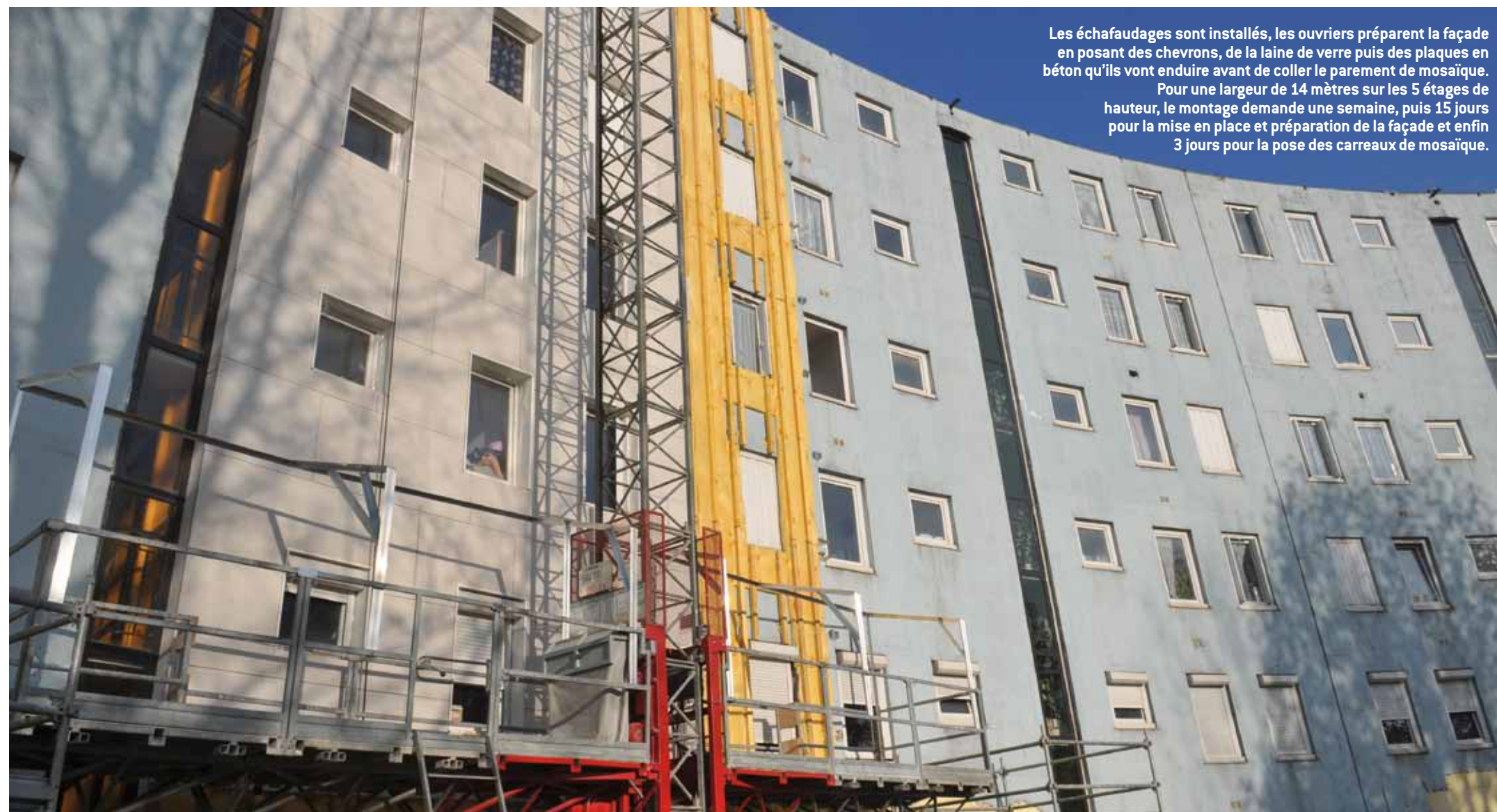
La façade du Serpentin reçoit des madriers recouverts d'une plaque de béton avant d'être revêtue de mosaïque.
